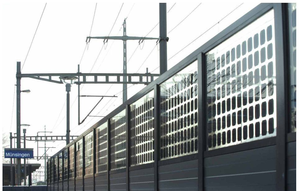
Energiapolitik heisst kreativ sein, wie das Beispiel der Lärmschutzwand in Münsingen zeigt, in die im oberen Teil Fotovoltaikzellen integriert sind.
