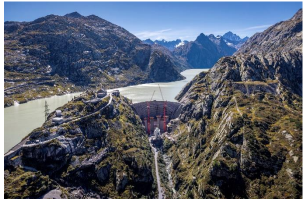
Abbildung 3: Grimselgebiet mit bestehender Staumauer. © David Birri, KWO
