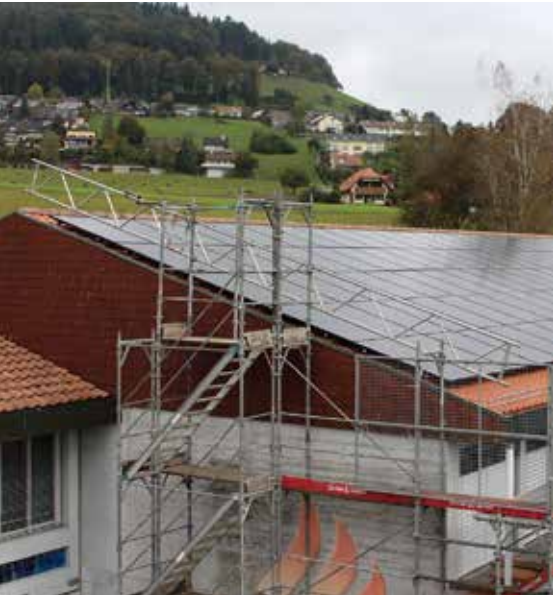
Optima Solar installiert eine Anlage auf dem Schulhaus in Boll.
